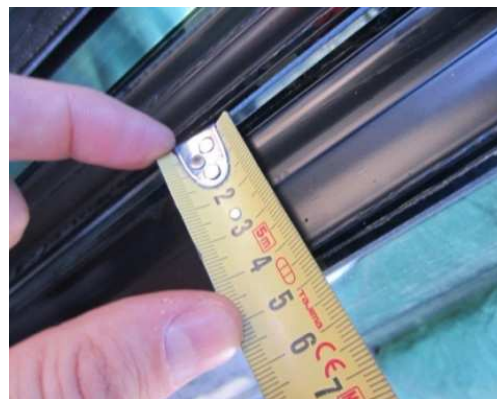
Vetrata triplo vetro basso emissivo. Serramento a taglio termico SCHÜCO
